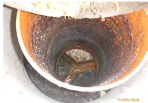
Kum med avløpsrør på tomten.
