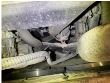
20. Utvendig tilstand motor
