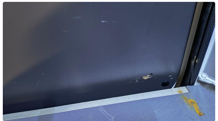
2.1 Deksler skadet/mangler
