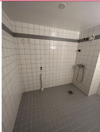
Opplegg vaskemaskin og tørketrommel.
