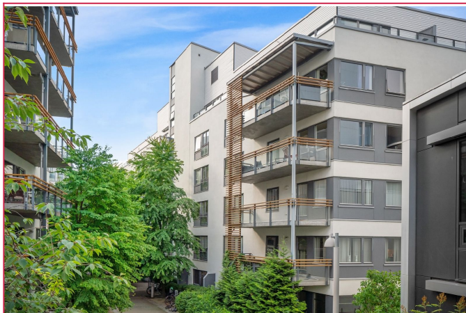
Romslig 2-romsleilighet med attraktiv beliggenhet. Oppvarming varmtvann og tv inkludert.
