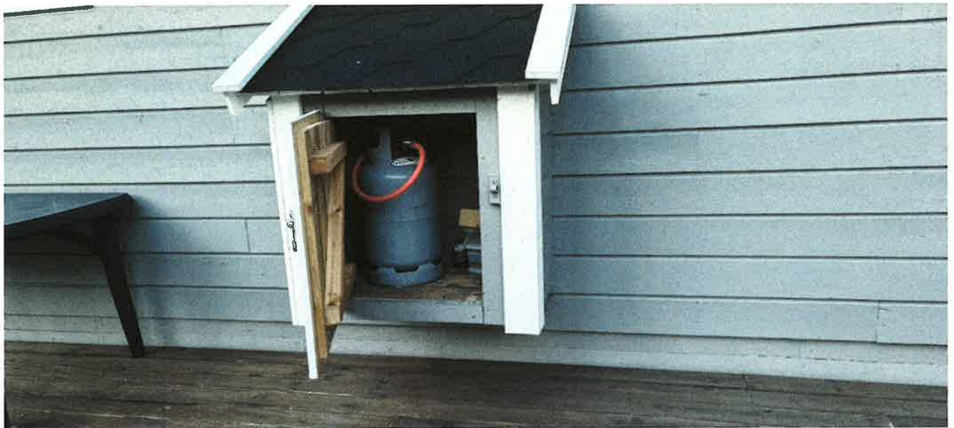
Utvendig skap til gassflasker. Plass til 2 gassflasker, kobberør fra skap og inn
