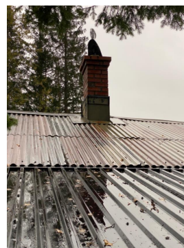
Tak mellom hoveddel og tilbygget del.
