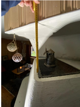
Åpning fra peisovn til brennbart materiale.
