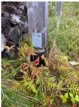
Søylepunkt mot nordvest. Råteskader i søyle.
