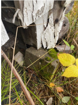
Søylepunkt mot nordvest. Råteskader i søyle.
