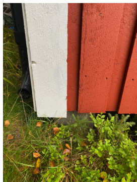
Kledning bør heves min. 15 cm. fra marknivå.
