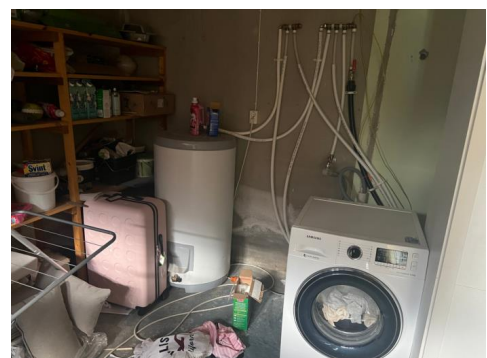
Vaskerom i kjeller. Dette er også teknisk rom
