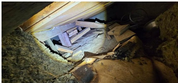
Lav høyde i krypkjeller
