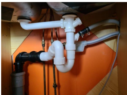
Rørproplegg i kjøkkenbenk.
