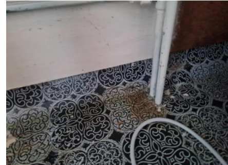
Rørgjennomføringer i gulv.
