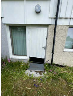
Biingang underetasje fuktskadet i nedkant
