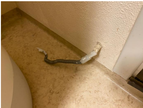
Tidligere tilkobling av varmtvannsbereder
