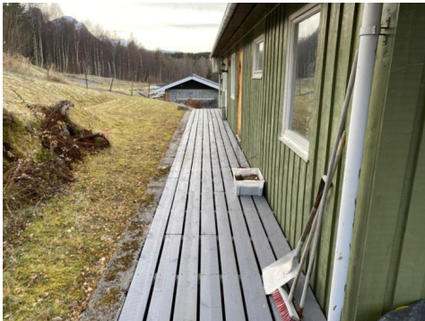
Treplattung langs fasade
