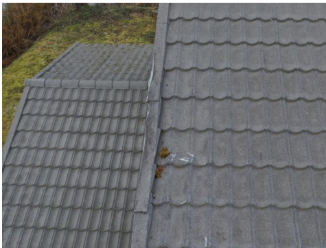
Skadet gavlbeslag
