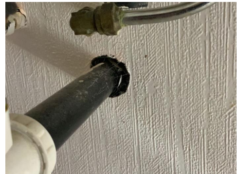
Rørgjennomføring i våtsone
