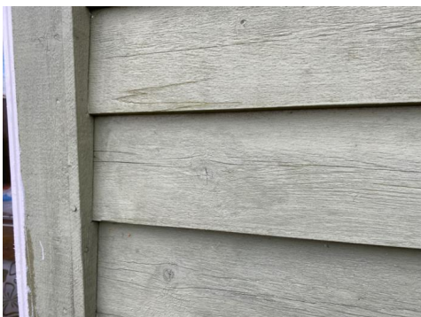
Malingsslitt trekledning
