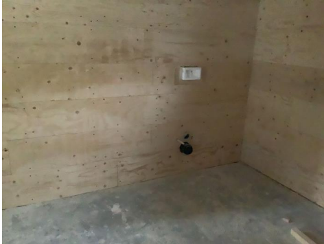
Klargjort til vegghengt toalett.
