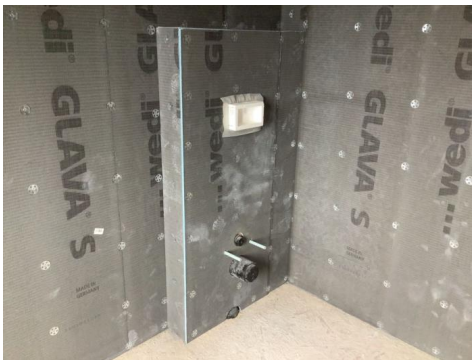
Klargjort for vegghengt toalett.
