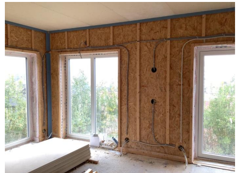
Trekkerør og påbegynt skjult el-anlegg på stue 1. etasje.
