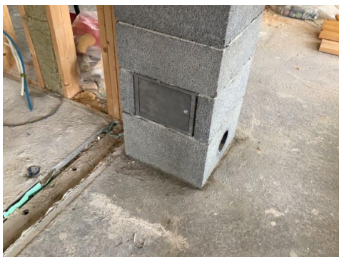
Sotluke plassert på stue.
