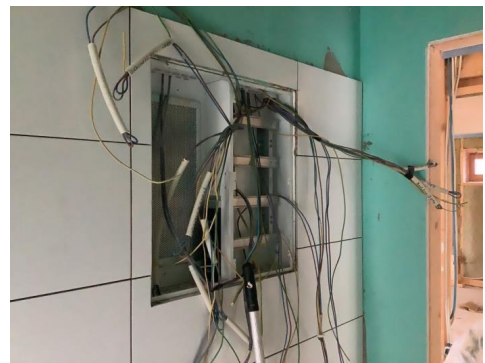
Planlagt område for sikringsskap på teknisk rom.
