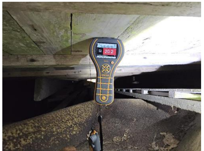
Krypekjeller - [Fuktmåling, kryperom]
