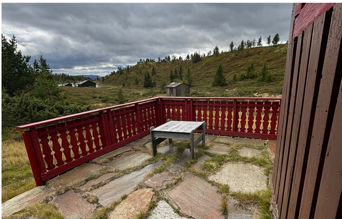
Fine uteplasser både på sør og nordenden av hytta. Bygget med ringmur av skifer og med skiferdekke.
