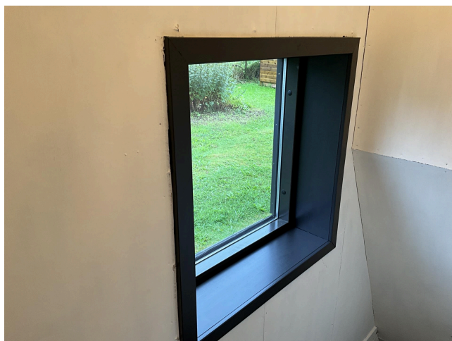
Nytt vindu fra 2024
