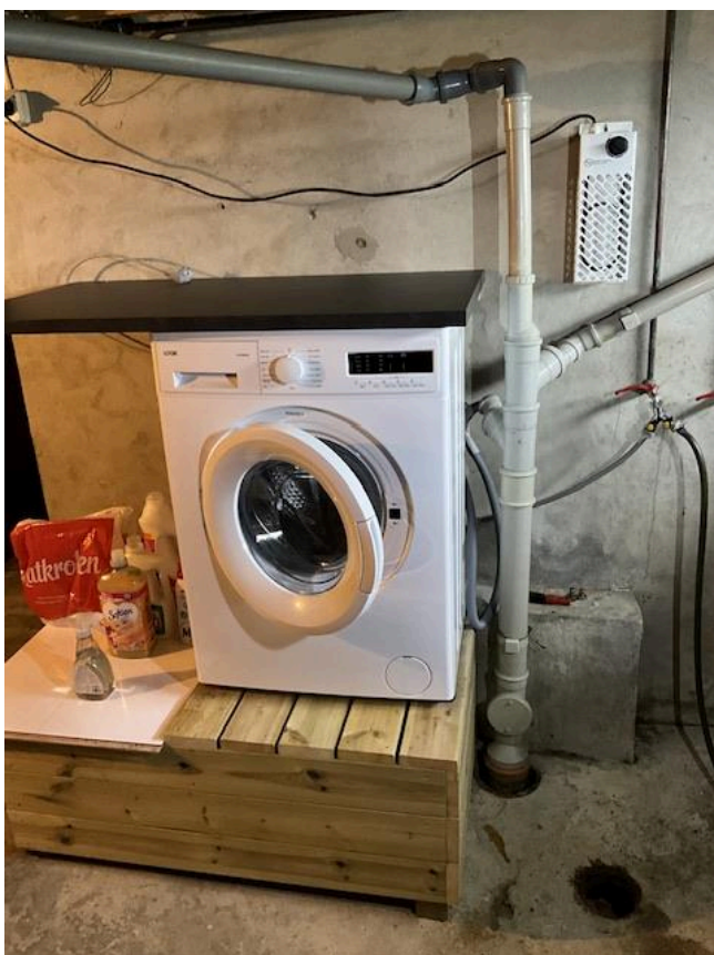
Vaskemaskin med støpejerns sluk til høyre.
