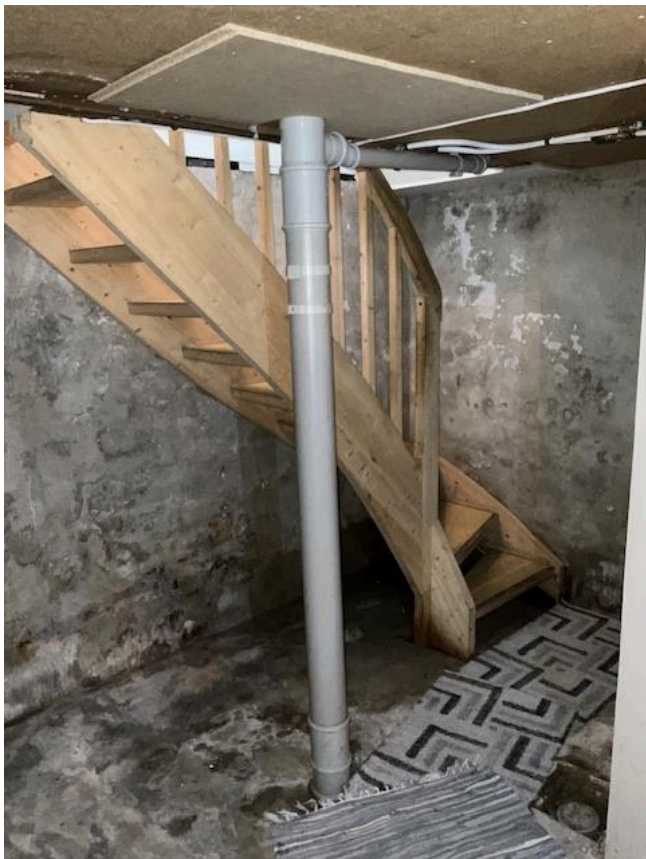
Trapp ned til kjeller.
