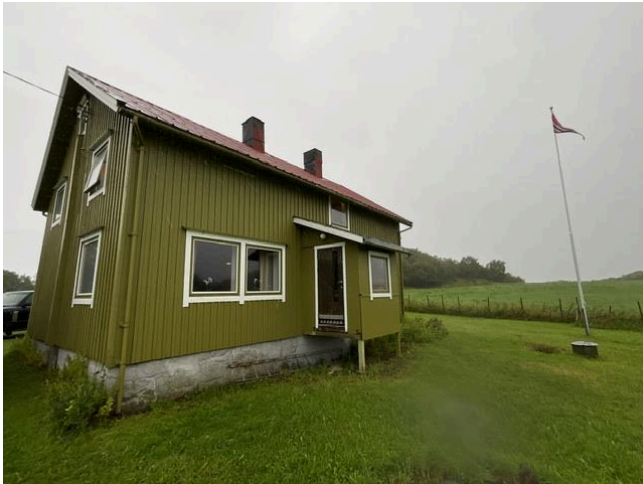
Trapper til tilbygget mangler.
