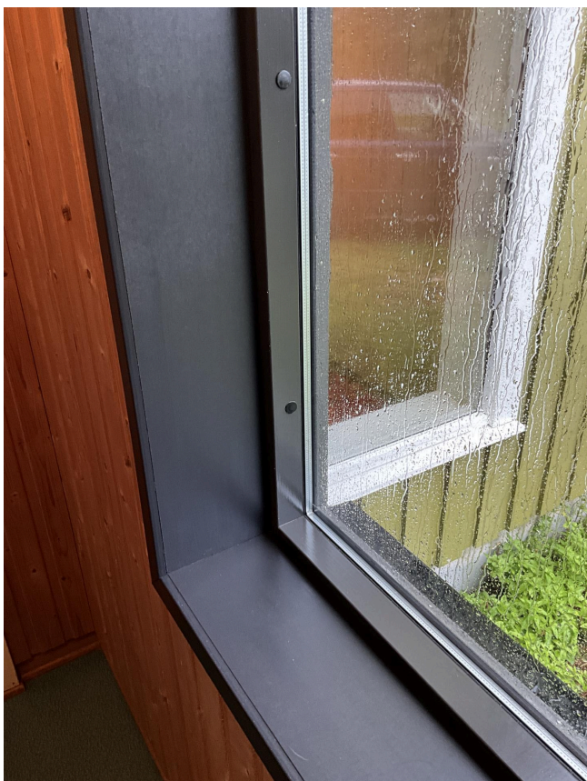
Nytt vindu fra 2024
