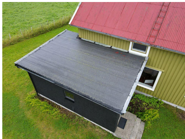
Tak på tilbygget med asfaltpapp.
