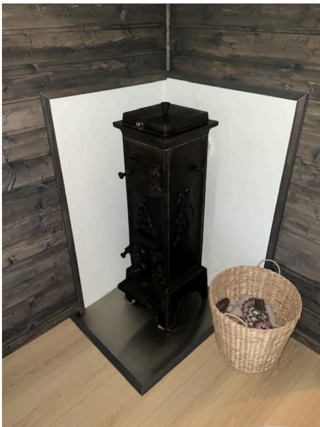
Vedovn på soverom i andre etasje.
