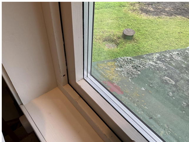
Vindu av ukjent alder med nytt glass fra 2024
