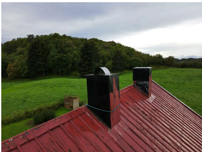
Skorsteiner har beslag av metall over taktekke.
