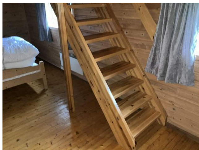
Tapper i soverom til hems. Trappen mangler gelender på venstre side.
