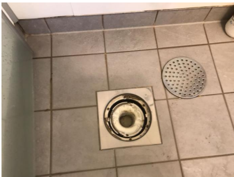
Fuger, Silicon og sluk
