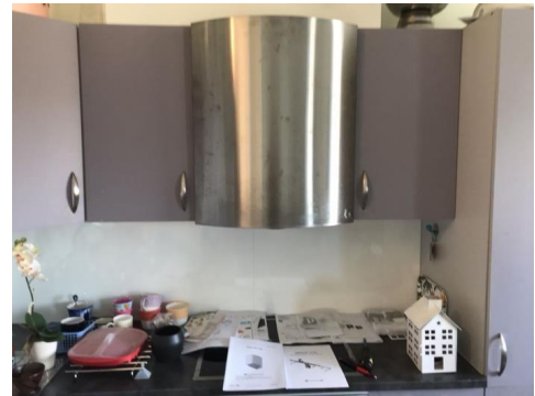
Avtrekk med filter og komfyrvakt
