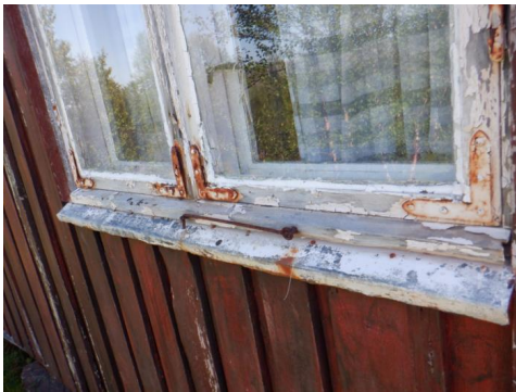
Råteskadet vindu.
