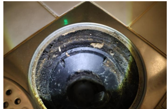
Dusjkabinett må brukes i rommet. Det er ikke tilstrekkelig fall til sluket.
