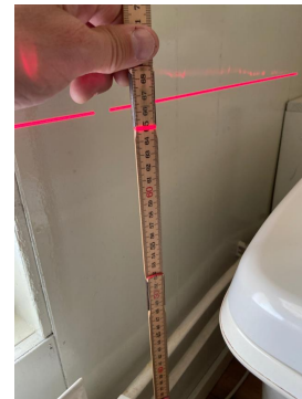
Bilde viser målt høydeforskjell på toalettrom.
