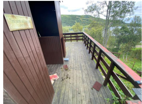
Bilde av veranda ved hovedinngang.
