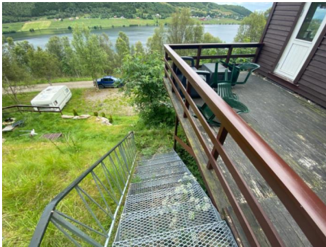
Utvendig trapp på vestsiden av fritidsboligen.
