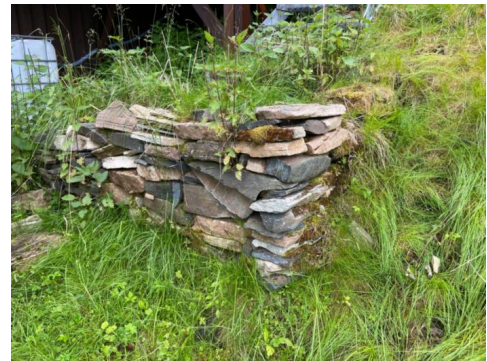
Bilde viser mur nedenfor trapp av strekkmetall.
