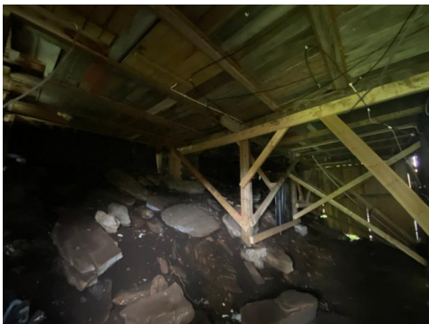
Bilde fra krypkjeller.
