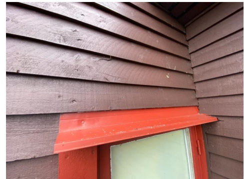
Bilde viser beslagsløsning over vindu på "Bad"
