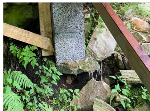
Bilde viser fundament.
