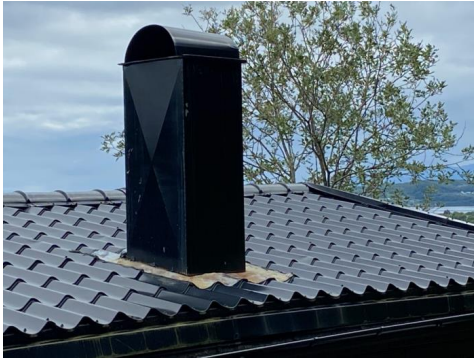
Bilde av pipebeslag samt deler av takrenne.
