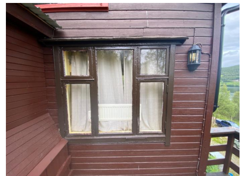
Vindu i stue. Det er montert ovn i vindu.
