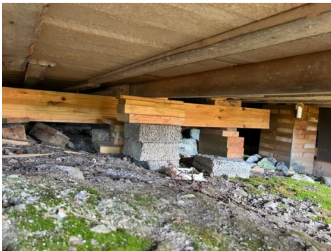
Enkel/ufagmessig fundamentering rett på terreng
