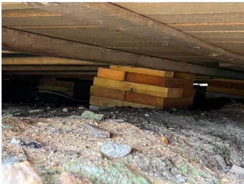
Enkel/ufagmessig fundamentering rett på terreng
