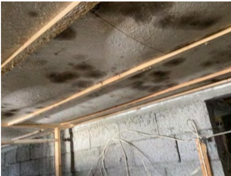
Eksempel på omfattende fuktskade (himling)
