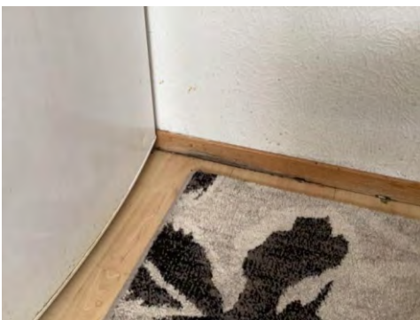
Fuktskadet gulv
