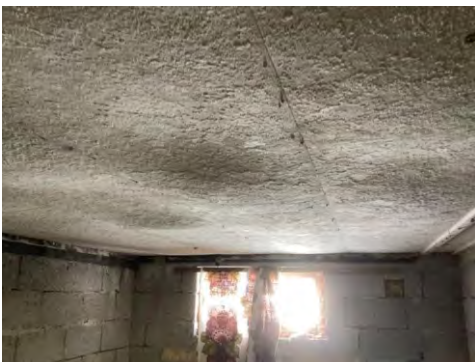
Eksempel på omfattende fuktskade (himling)
