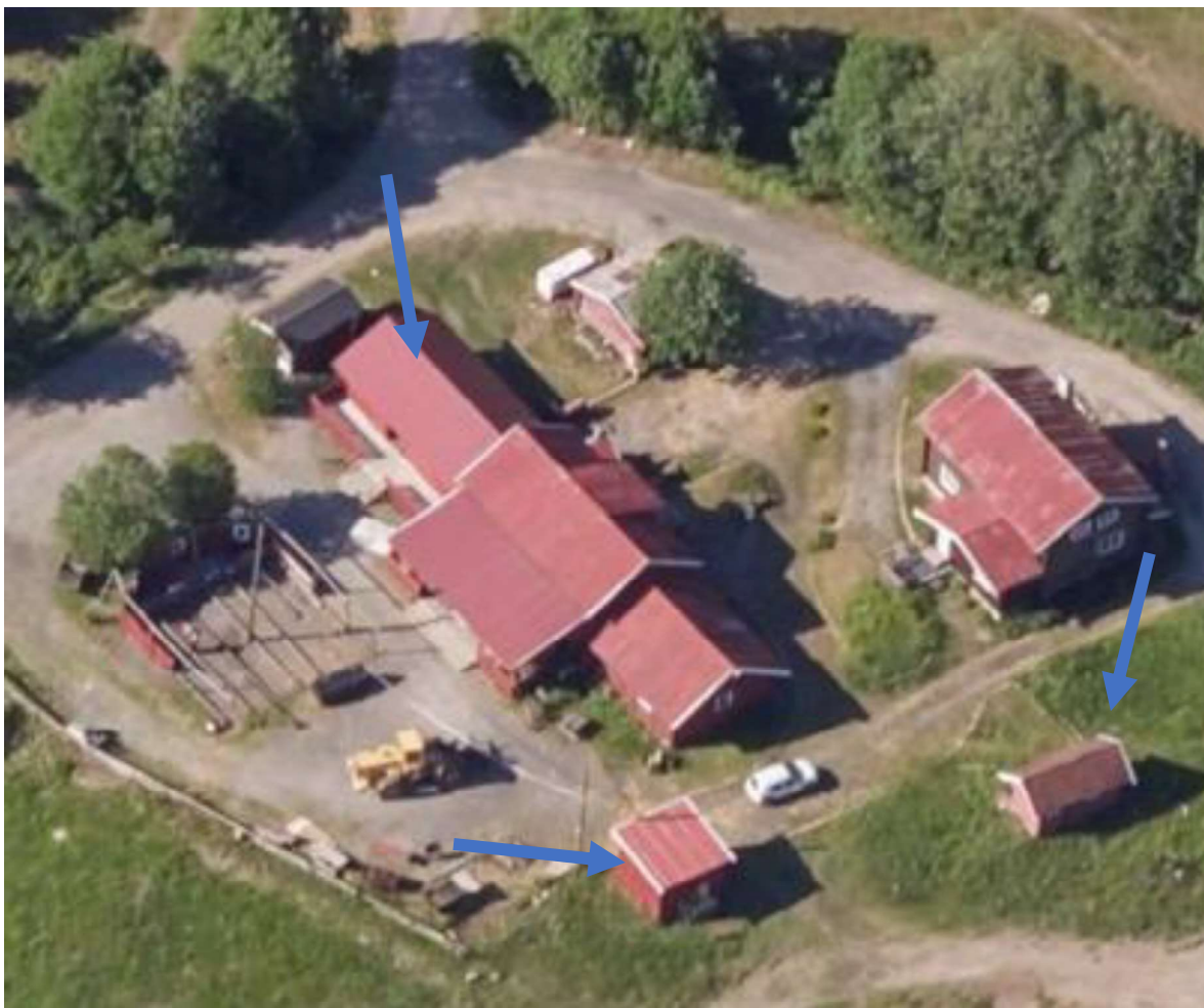
Ulovlig påbygg/bygg vises med blå piler.
