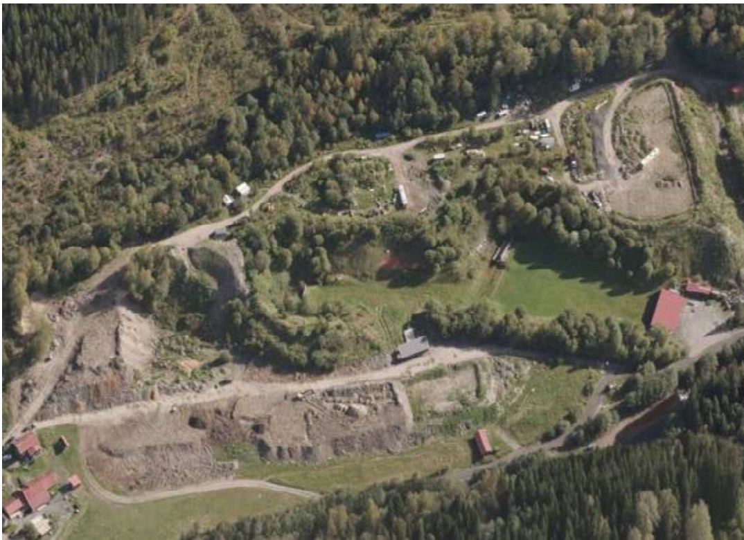
Flyfoto fra 2016 som viser pågående fyllvirksomhet på deler av eiendommen.
