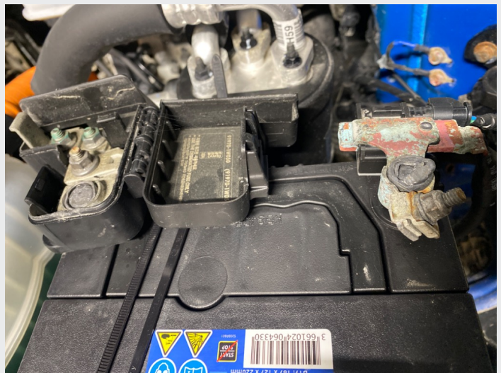
5.2 Batteri ledninger sitter ikke godt på polene, er dårlige poloverganger
