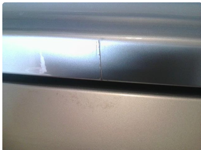
1.2 Ripe(r) ned til grunning
