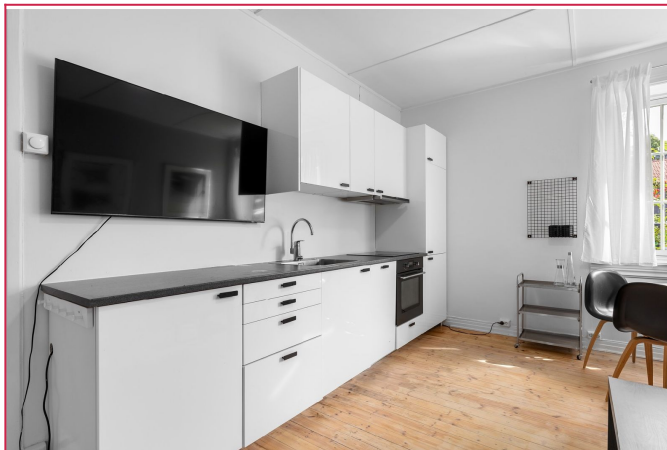
Ikea kjøkkeninnredning med slette folierte høyglansfronter og laminat benkeplate.
