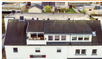
Skrå takdel med takoppløft.
