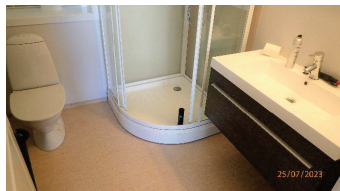
Baderomsinnredning leilighet sørøst:
