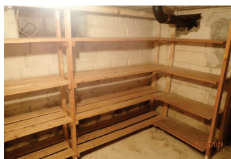
Forblendede vegger med betonghulstein.
