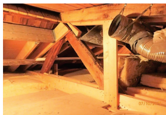
Takkonstruksjon under møne mot takløft.
