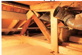
Takkonstruksjon under møne mot takløft.
