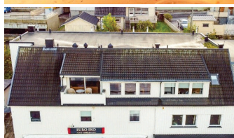
Skrå takdel med takoppløft.
