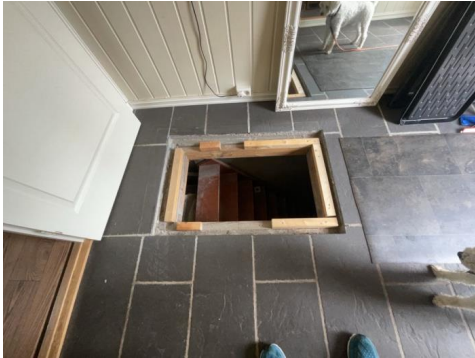
Kjellerluke i gulv entré
