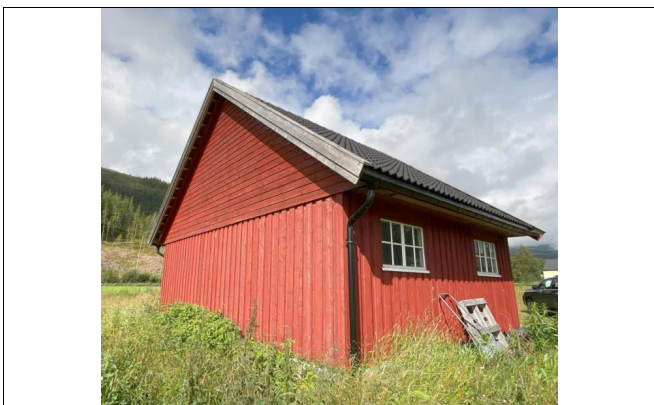
Baksiden av garasjen
