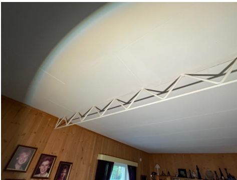
Gitterdrager montert i tak v/ stue 1.etasje
