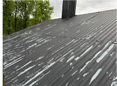
Stedvis bunglete og flassete maling.
