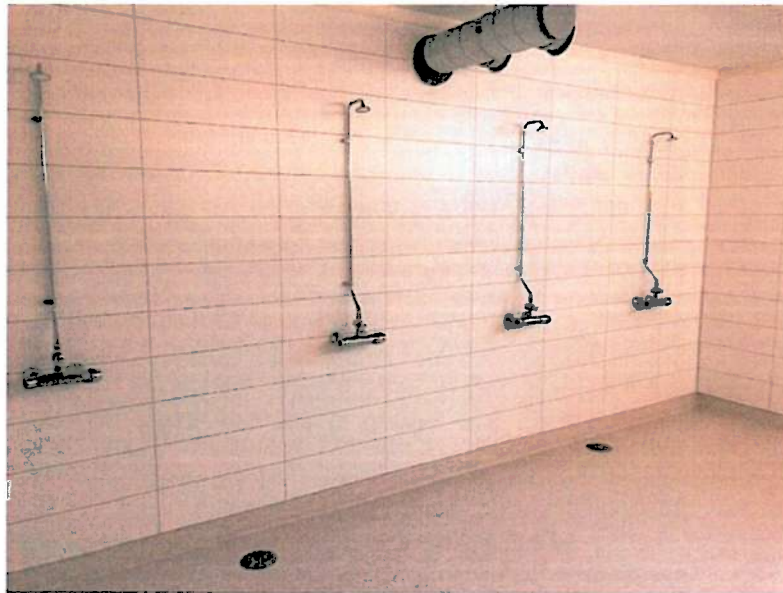
Dusjrom i garderobeanlegget (80-tallsbygget)
