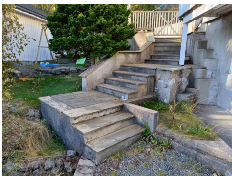
Utvendig trapp vendt mot sør.
