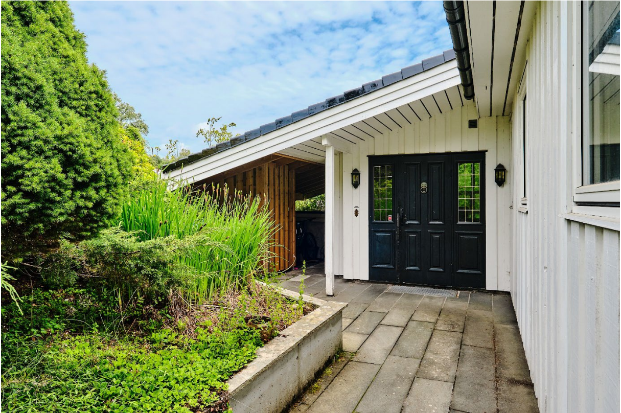
Overbygget inngangsparti til 1. etg
