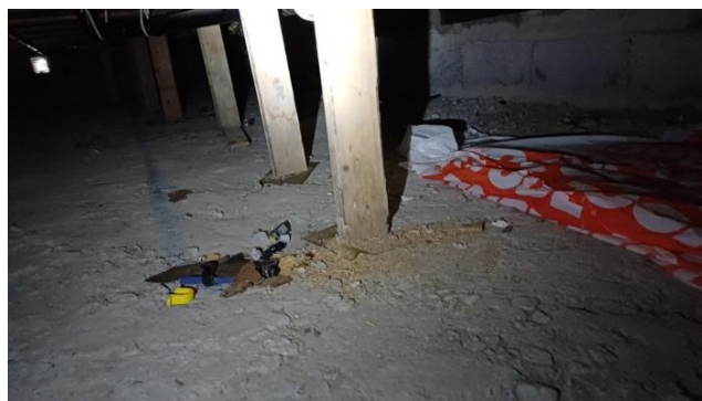
Støtter under bjelkelag er ikke forankret tilstrekkelig.
