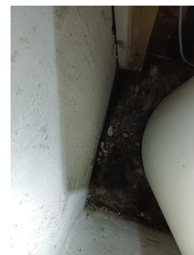
Støtter under bjelkelag er ikke forankret tilstrekkelig.
