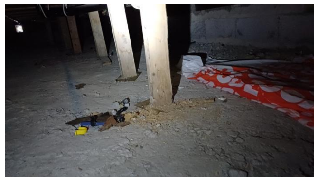
Støtter under bjelkelag er ikke forankret tilstrekkelig.
