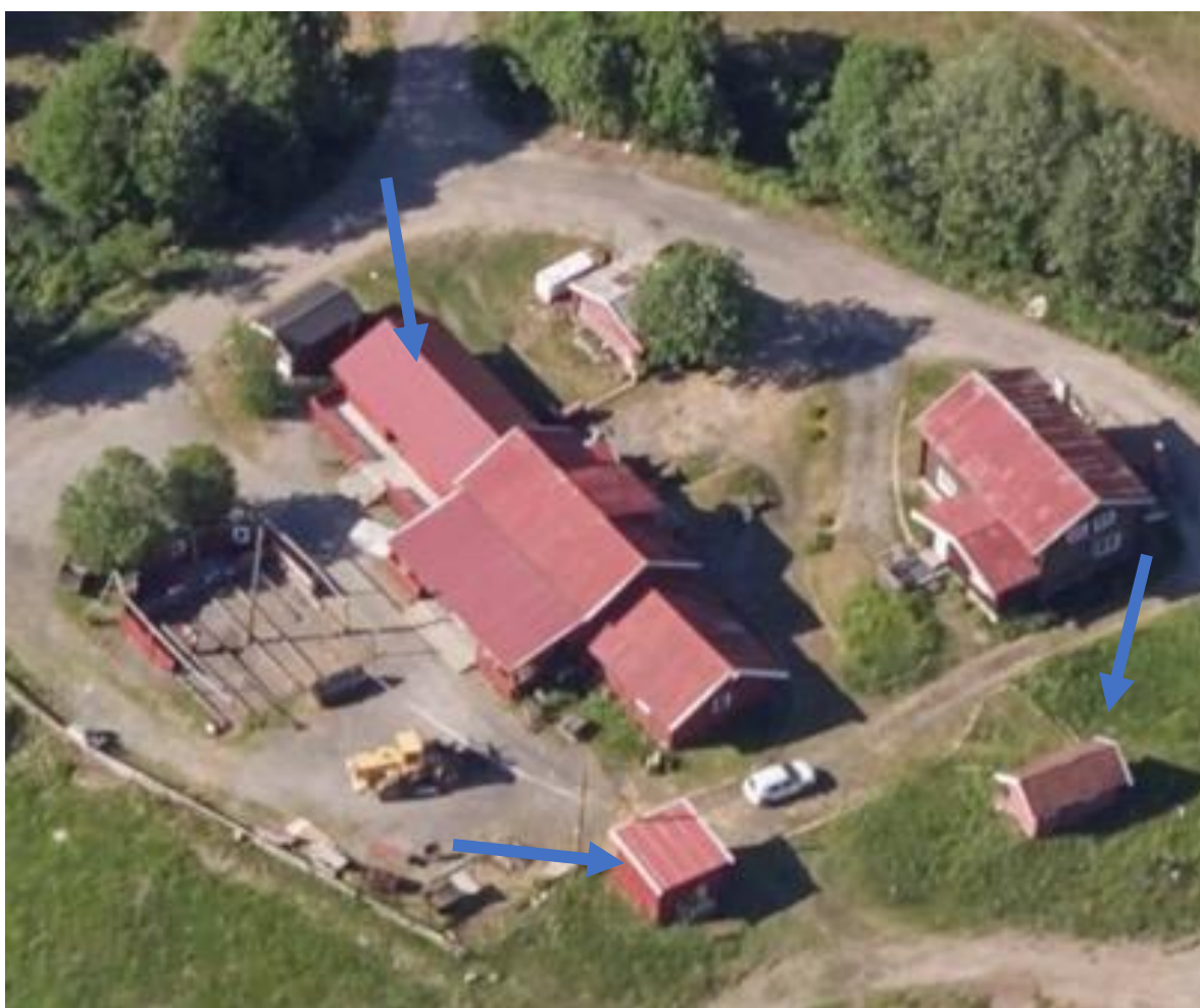
Ulovlig påbygg/bygg vises med blå piler.
