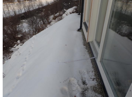
Usikret terreng nedside bolig.
