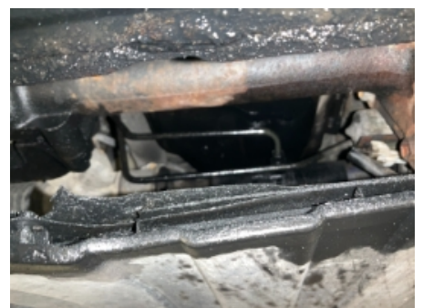
60. Utvendig tilstand motor
