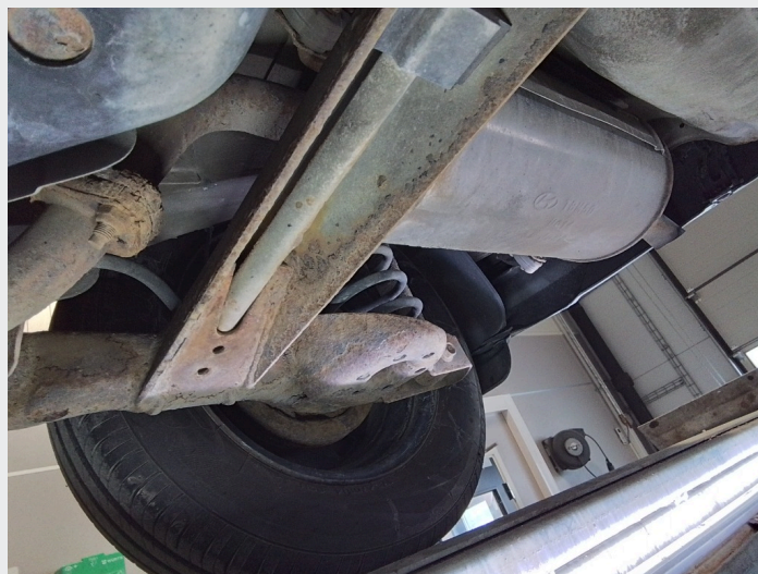
8.4 Mye overflaterust på travers foran og bak
