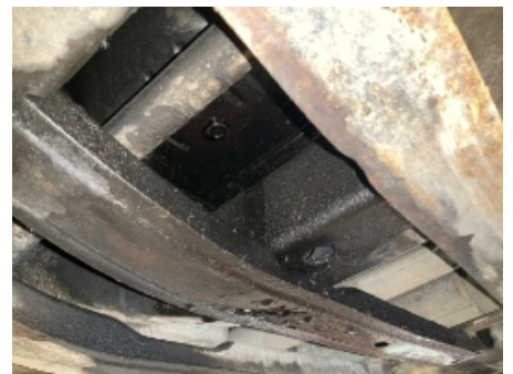
30. Utvendig tilstand motor
