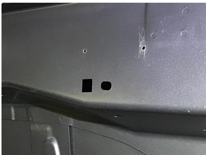
1.2 Demontering av innredning/utstyr
