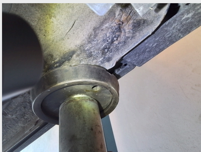
2.2 Avflassing ved kanaler venstre side
