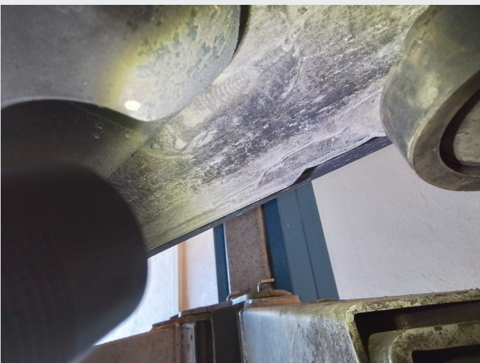
2.2 Avflassing ved kanaler venstre side
