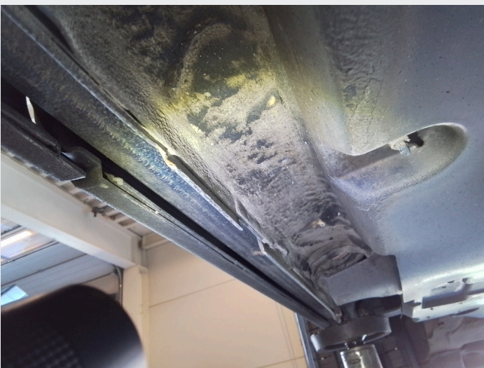
2.2 Avflassing ved kanaler høyre side
