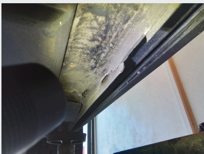
2.2 Avflassing ved kanaler venstre side
