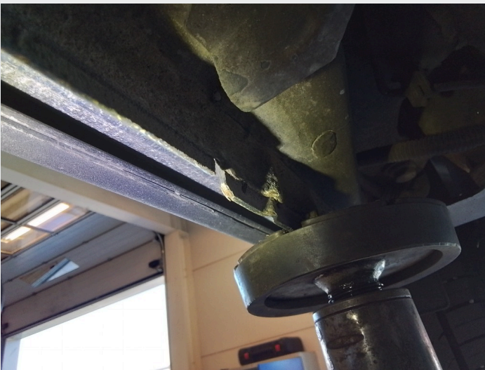
2.2 Avflassing ved kanaler høyre side
