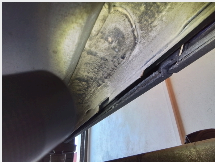
2.2 Avflassing ved kanaler venstre side
