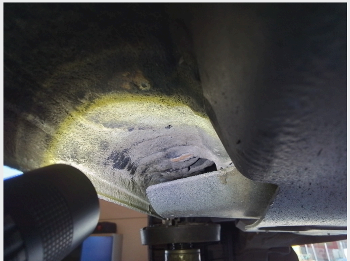
2.2 Avflassing ved kanaler høyre side
