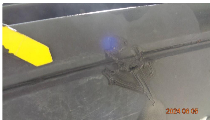
1.1 Skrubbskader underkant med hull støtfanger foran
