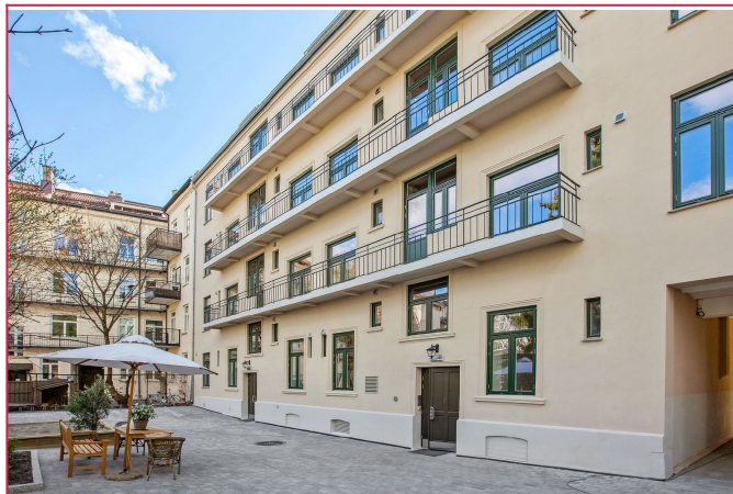
Bakgård med sittegruppe, sykkelparkering og felles brannbalkonger
