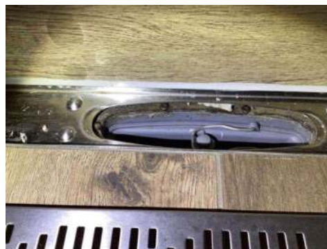
Membran/ mansjett påvist i sluk.
