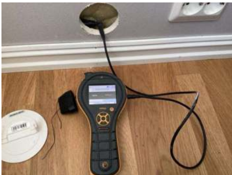
Måling med pigg, under 8vekt % (31.05.2024)
