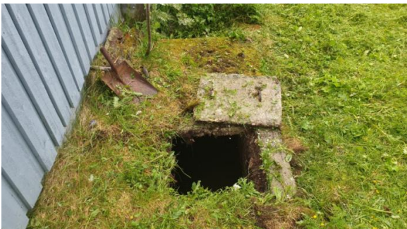
Kontroll av septiktank som ikke er i bruk.
