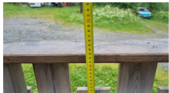
Kontroll av rekkverkshøyde.
