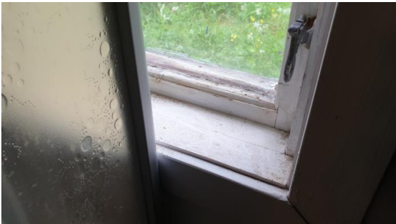
Vindu montert i våtsonen av rommet.
