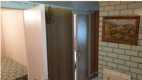
Pipe i loftsetasje er igjenkledd med treplater med flismønster.
