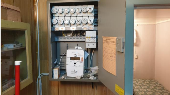
Kontroll av el-skap og kursfortegnelse.
