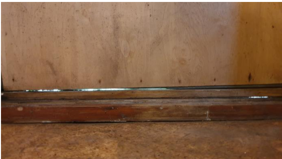
Dør mot vest (i mellomgang) har utettheter.
