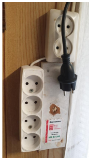
Provisorisk fast tilkobling av strømpadde kjøkken.
