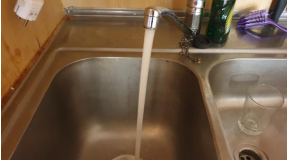
Kontroll av vanntrykk (vanntrykket er tilfredsstillende)
