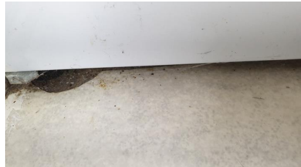
Belegg er avsluttet rett under dusjkabinett.
