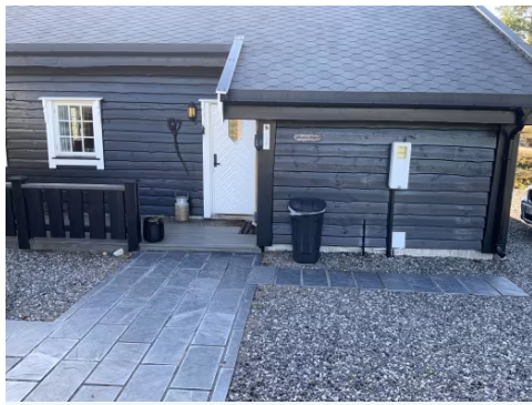
Viser fasade hvor panel er avsluttet nært terreng.
