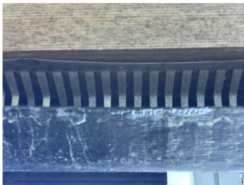
Viser lufting av kledning og bruk av musebånd.
