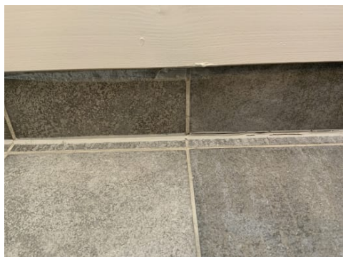
Viser sprekkdannelser i mykfug og overgang gulv / vegg.
