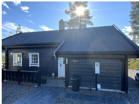
Viser del av taktekking.
