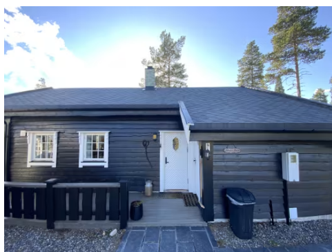
Viser tak med manglende snøfangerer og takstige.
