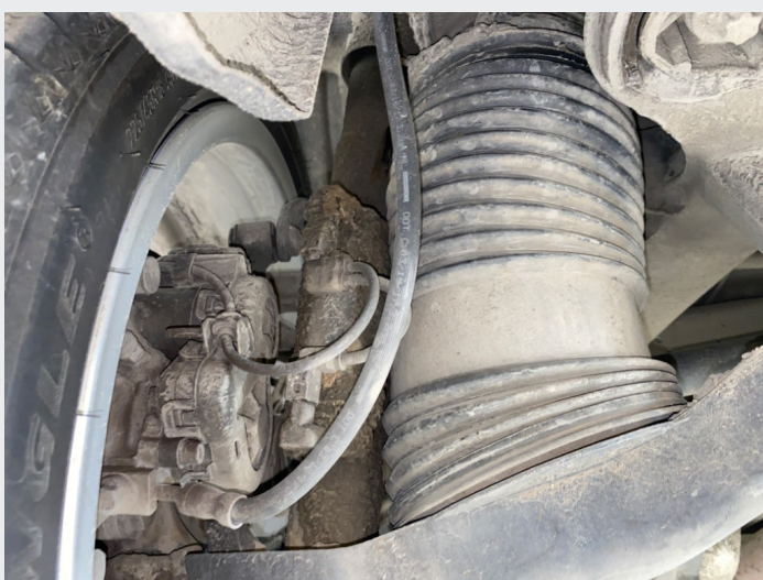
8.6 Svetting demper VB. Har fortsatt normal funksjon
