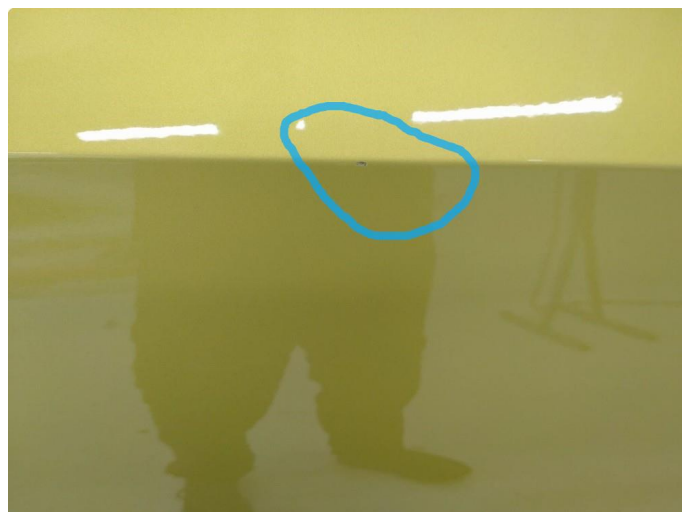
1.2 Ripe ned til grunning
