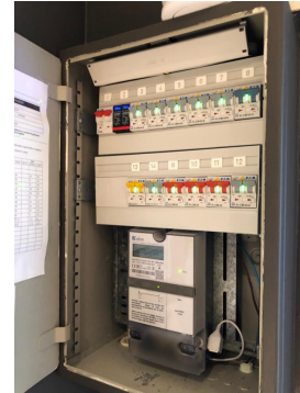
Sikringskap med automatiske sikringer.
