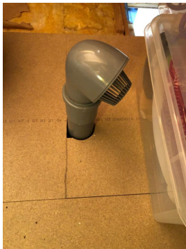
Avløpsledninger i plast, fra byggeåret.
