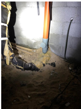
Avløpsledninger i plast, fra byggeåret.
