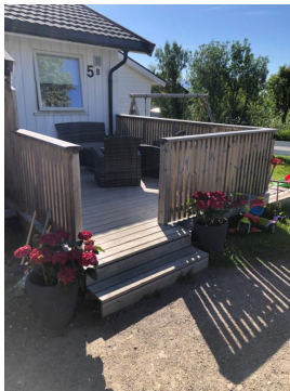
Oversiktsbilde trapp ved hovedinngang.
