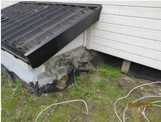
Bilde tatt mot støttemur for kjellernedgang utvendig
