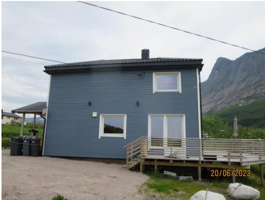
Bilde tatt mot ene fasade hvor det er balkong dør
