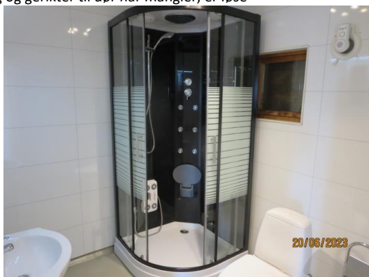
Bilde tatt mot dusjkabinett m/ dyse funksjoner, vindu v/ kabinett og fukt styrt vifte, Wc.
