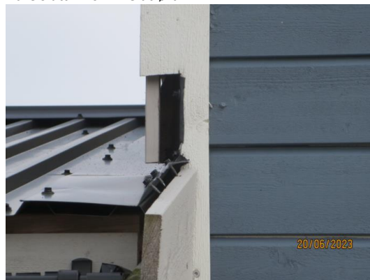
Mindre mangler, slutt finish mangler til beslag og hjørne bord
