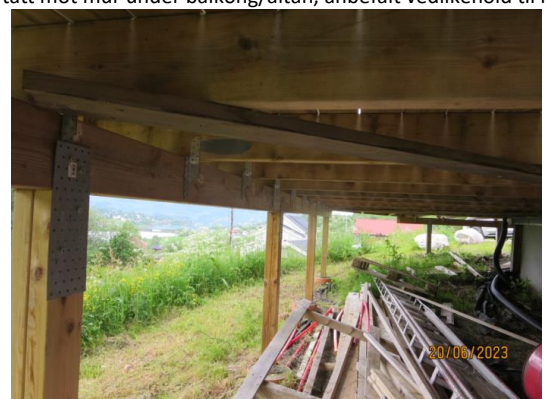
Bilde tatt mot BMF plate montert i overgang søyle og dragere, anbefalt montert flere innfestings skruer
