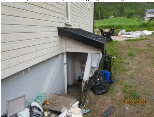
Bilde tatt mot støttemur for kjellernedgang utvendig
