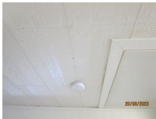
Montert brann melder i tak plan 2 etg.
