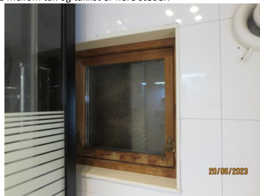
Bilde tatt mot vegg på bad hvor vindu er kledd igjen utvendig.
