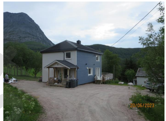
Bilde til del av adkomst, parkerings område
